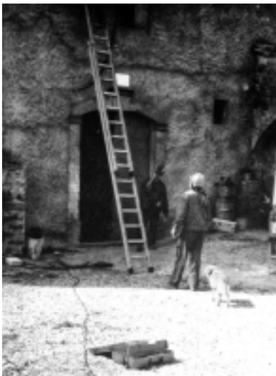
Cal Bolló, operaris posant la instal·lació elèctrica el 1993.
