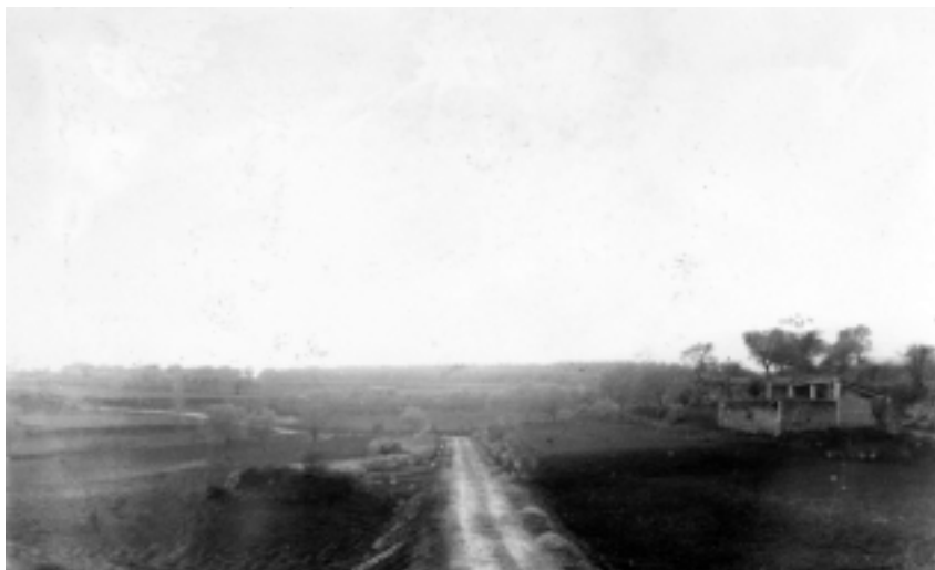
Carretera acabada, juliol del 1961.
